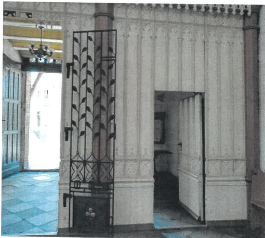
Zdjęcie nr 4 – drewniana ściana o grubości 12cm wydzielająca kryptę przed wyjściem głównym kościoła - autor zdjęcia W. Garbacewicz
