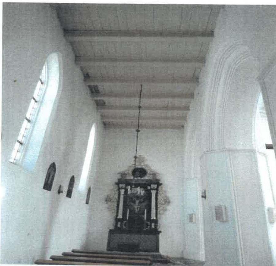
Zdjęcie nr 1 – strop drewniany nad nawą boczną kościoła - autor zdjęcia W. Garbacewicz
