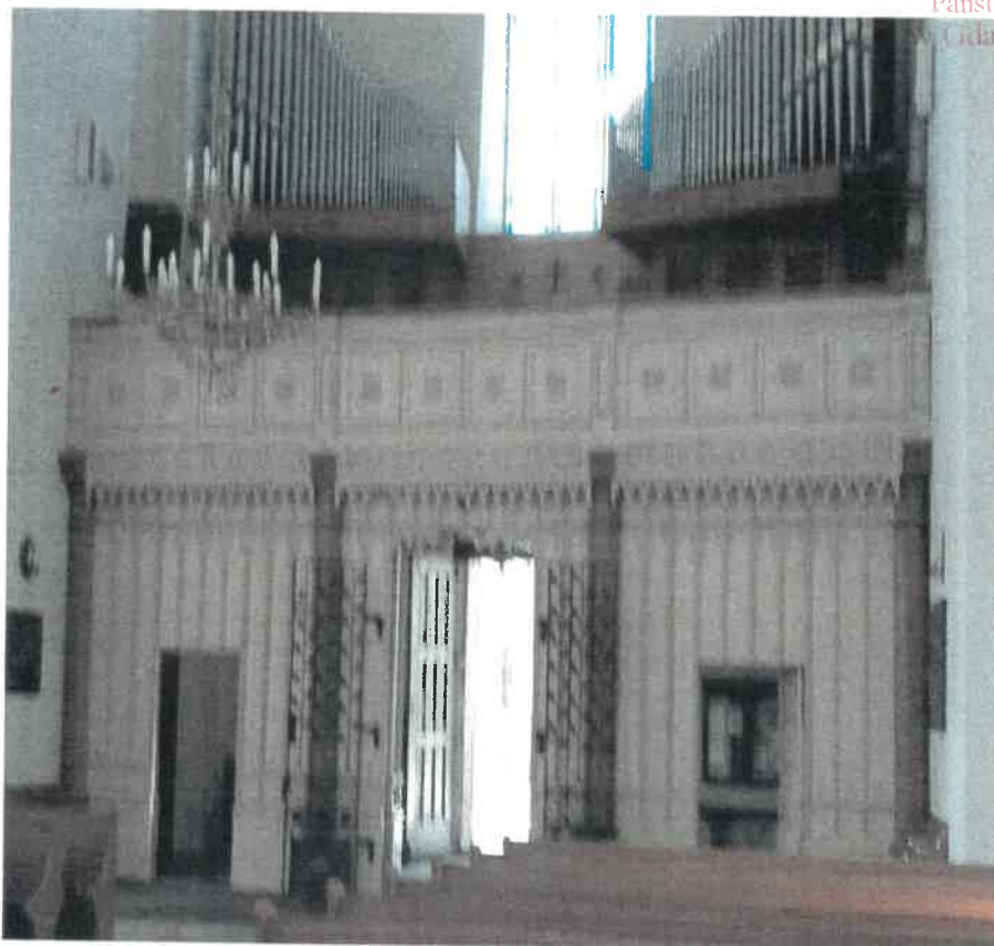
Zdjęcie nr 3 – drewniana ściana o grubości 12cm wydzielająca kryptę przed wyjściem głównym kościoła - autor zdjęcia W. Garbacewicz
